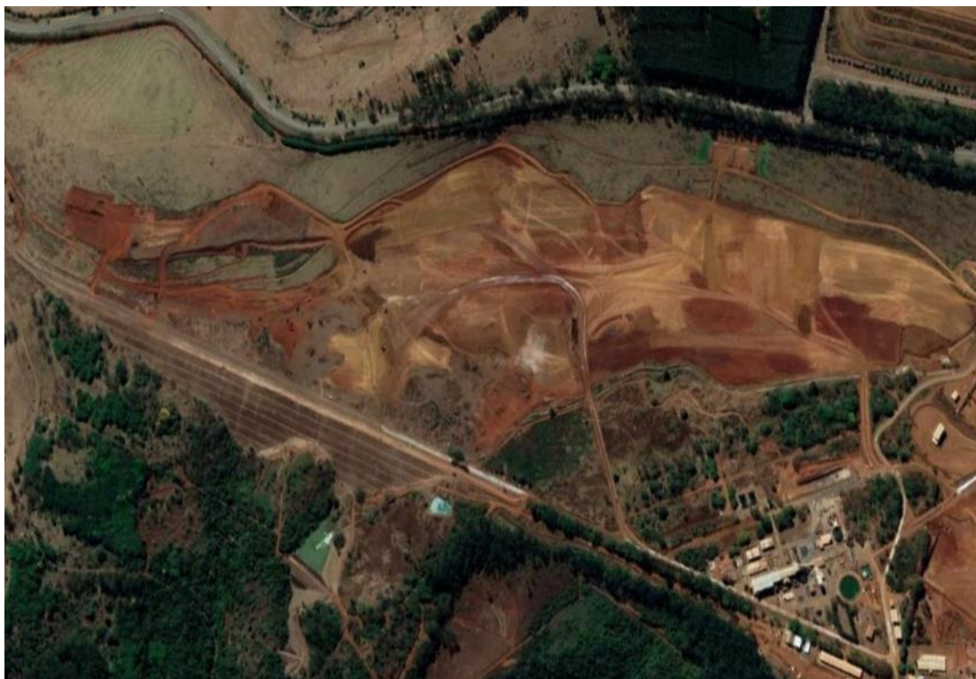
Figura 5-3: Vista aérea da Barragem B-4
