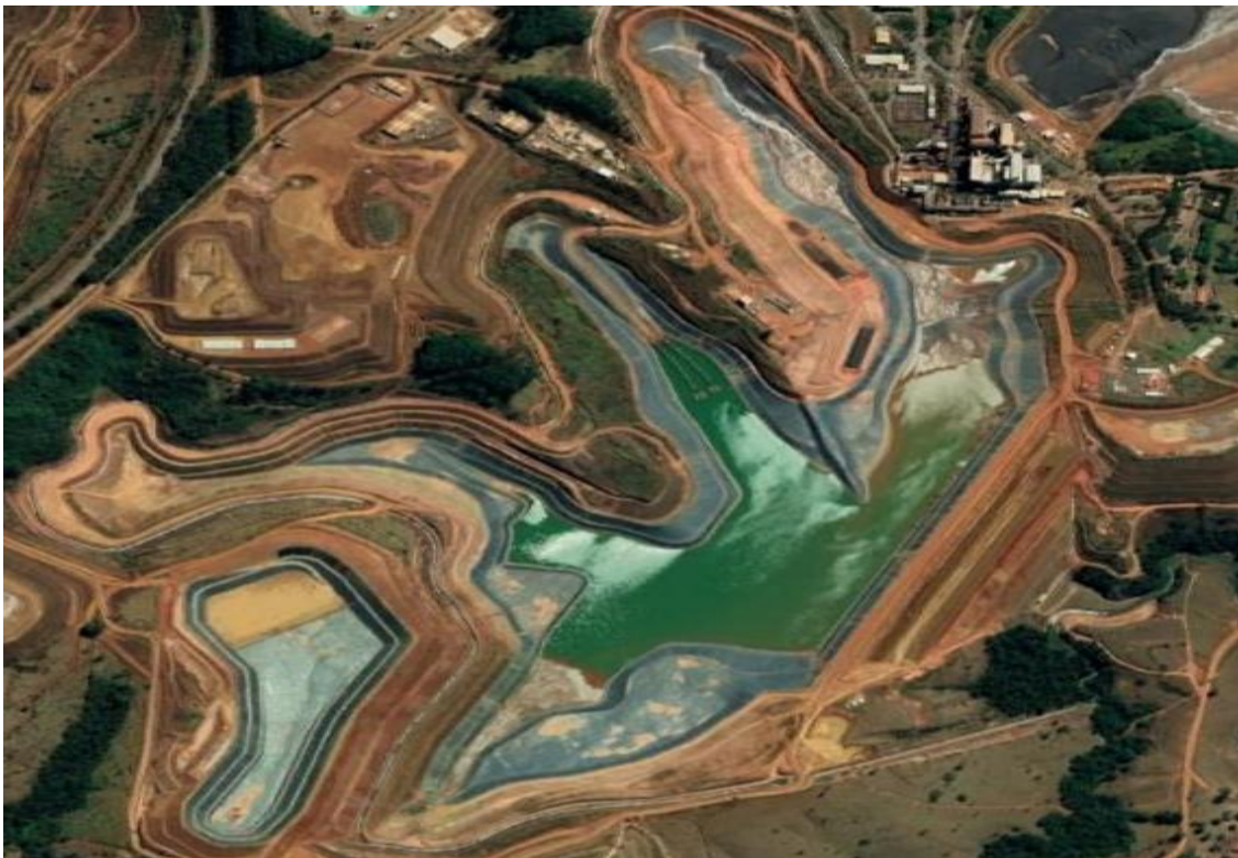
Figura 5-2: Vista aérea da Barragem de Rejeitos B-8.
