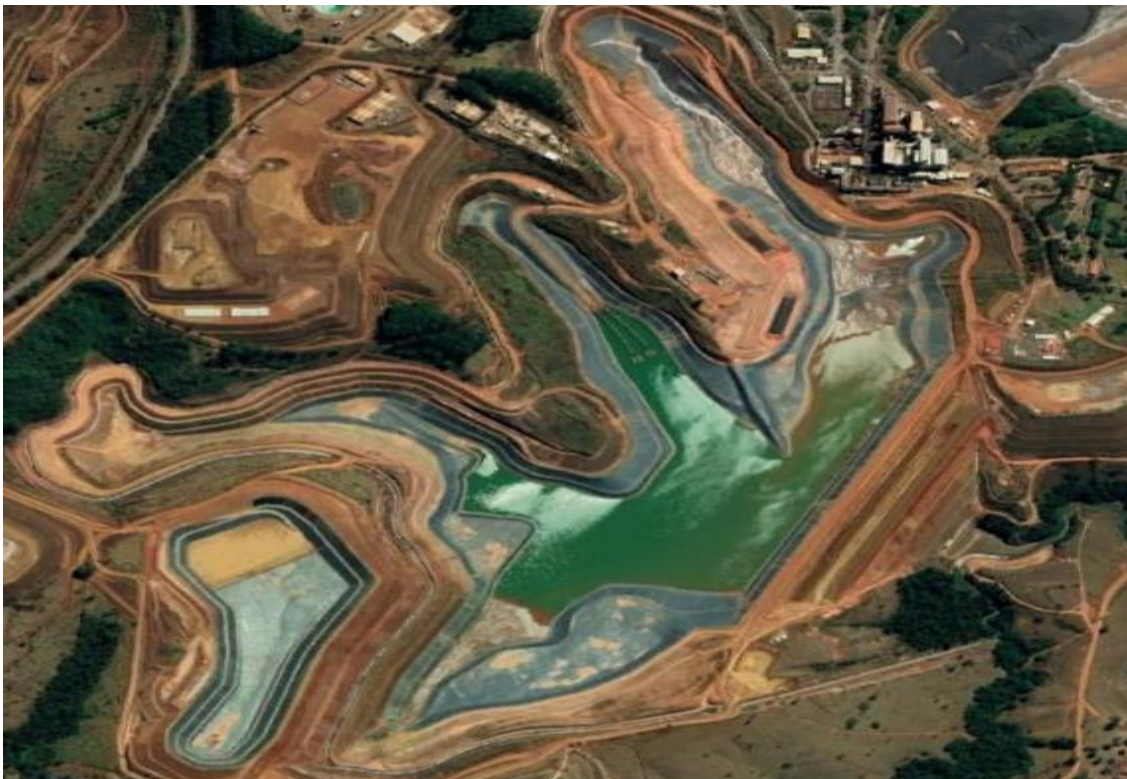
Figura 5-2: Vista aérea da Barragem de Rejeitos B-8.
