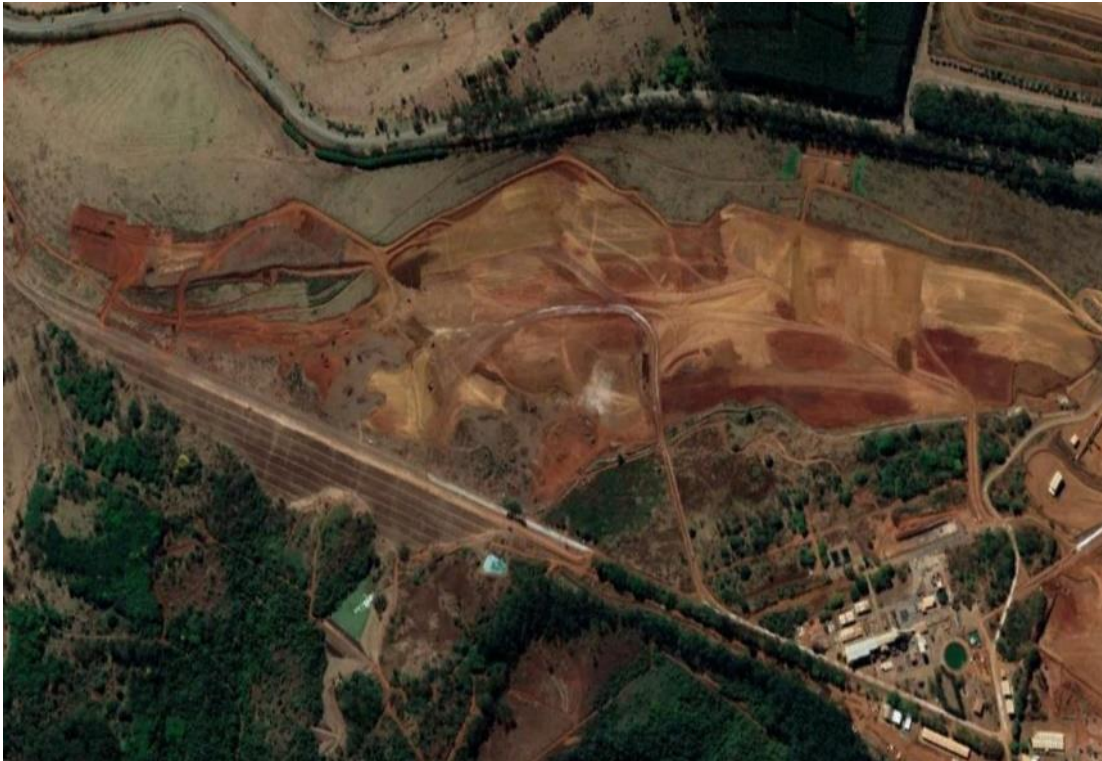
Figura 5-3: Vista aérea da Barragem B-4
