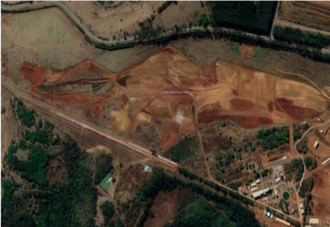
Figura 5-3: Vista aérea da Barragem B-4
