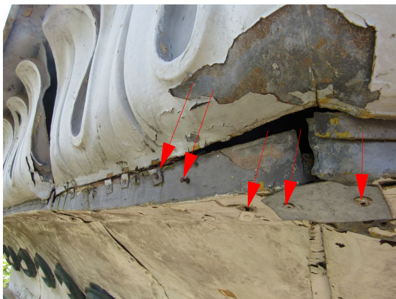
Figura 7: Coreto. Detalhe de danos causados no arremate do beiral devido à intervenções inadequadas com a utilização de recortes de chapas, pregos, rebites e/ou parafusos. Caxambu/MG. 09/2020. Foto: Equipe Estilo Nacional.
