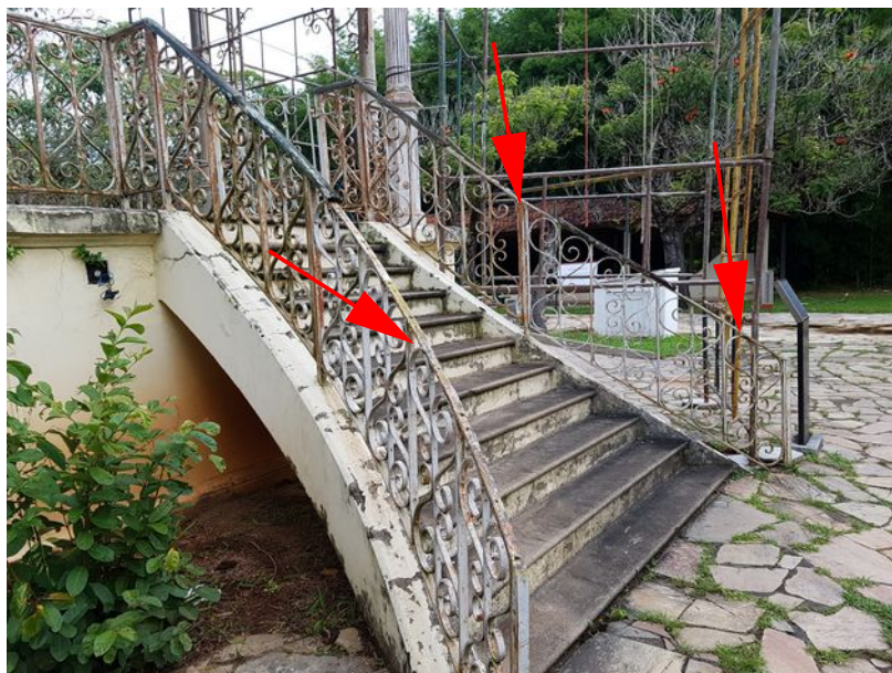
Figura 12: Coreto. Detalhe das áreas de perda da madeira do corrimão. Caxambu/MG. 03/2020. Foto: Equipe Estilo Nacional.
