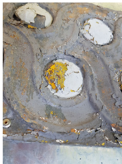
Figuras 3 e 4: Coreto. Detalhe de elementos apresentando desprendimento de policromia levando a perder as camadas originais de
