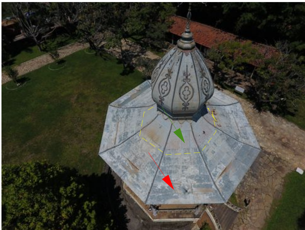
Figura 8: Coreto. Seta verde indica a área com chapas originais em forma de escamas e a seta vermelha a área de intervenção, com chapas de aço. Caxambu/MG. 03/2020. Foto: Equipe Estilo Nacional.
