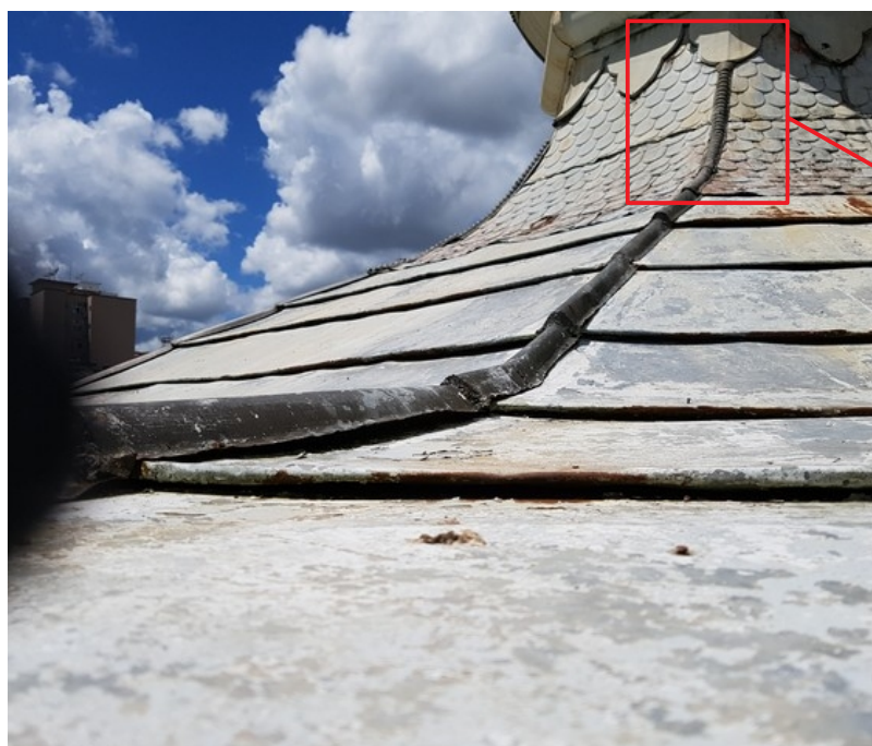
Figura 9 e 10: Coreto. Detalhe das intervenções realizadas sobre os espigões e peça de arremate original (à direita) indicada em
