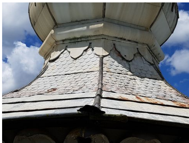
Figura 2: Coreto. Detalhe da cobertura com intervenções inadequadas e complementações com chapas de aço fixadas com rebites e/ou parafusos e massa plástica. Caxambu/MG. 03/2020. Foto: Equipe Estilo Nacional.
