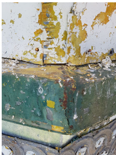
Figuras 3 e 4: Coreto. Detalhe de elementos apresentando desprendimento de policromia levando a perder as camadas originais de
