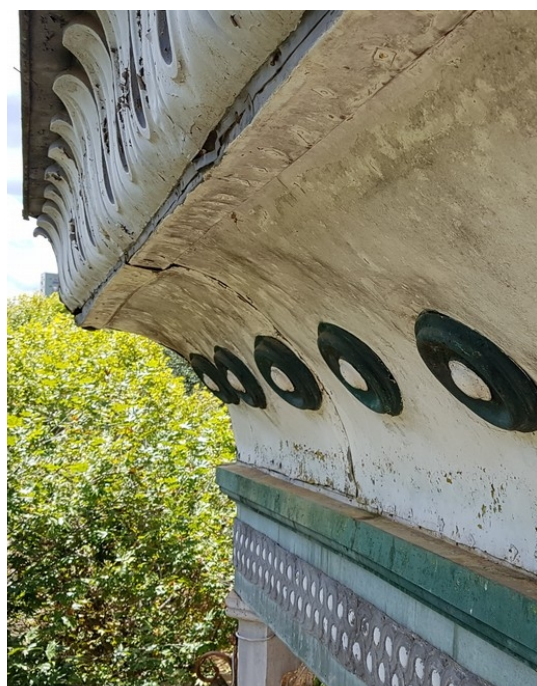
Figura 6: Coreto. Detalhe de trecho da platibanda que precisará de reforço com uma tala a fim de não provocar maiores danos a seu suporte e camada pictórica. Caxambu/MG. 03/2020. Foto: Equipe Estilo Nacional.
