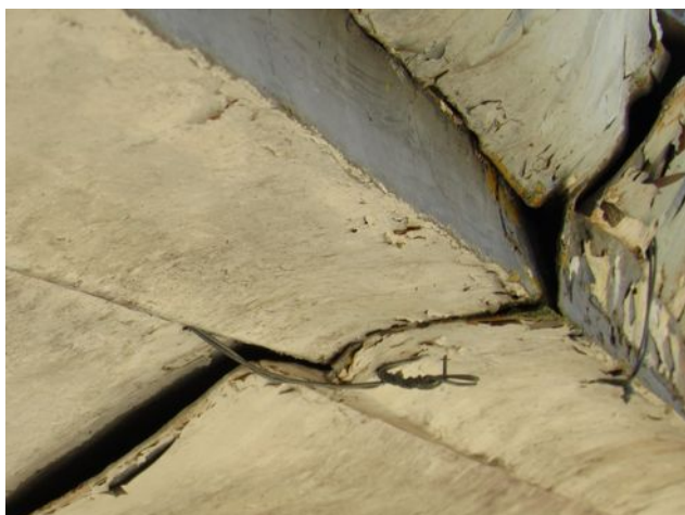
Figura 1: Coreto. Detalhe das chapas do arremate do beiral desalinhadas e com intervenções inadequadas, fixadas com pedaços de arame. Caxambu/MG. 03/2020. Foto: Equipe Estilo Nacional.
