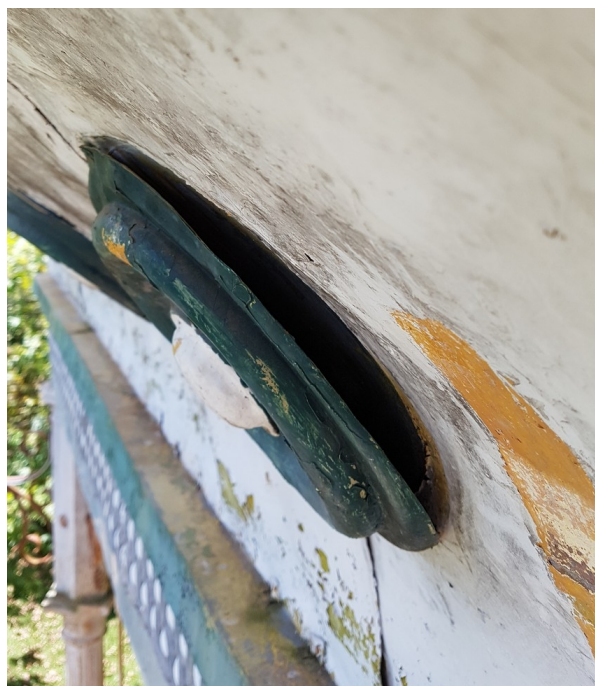
Figura 5: Coreto. Detalhe de elemento decorativo em desprendimento. Caxambu/MG. 03/2020. Foto: Equipe Estilo Nacional.
