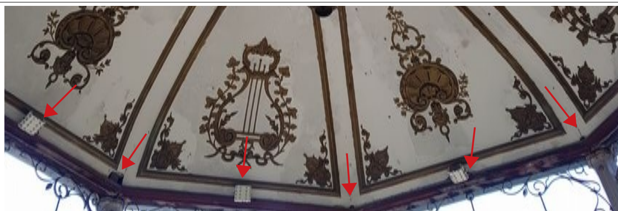
Figura 11: Coreto. Áreas do forro que foram perfuradas para passagem de fiação improvisada. Caxambu/MG. 03/2020. Foto: Equipe Estilo Nacional.
