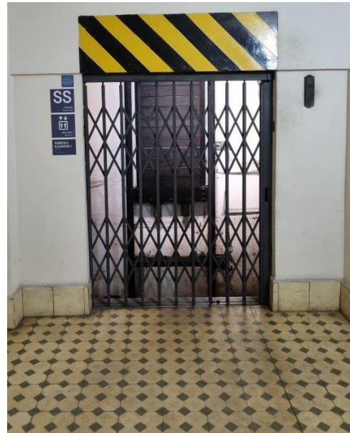
Figura 8 – Acesso ao elevador 1 pelo subsolo
