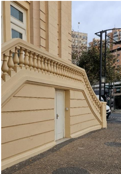
Figura 7 – Acesso pelo subsolo
