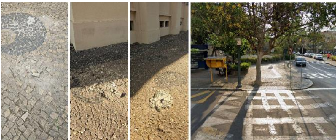
Figura 4 - Trechos nas calçadas que necessitam de recomposição. Árvore posicionada no alinhamento da travessia
