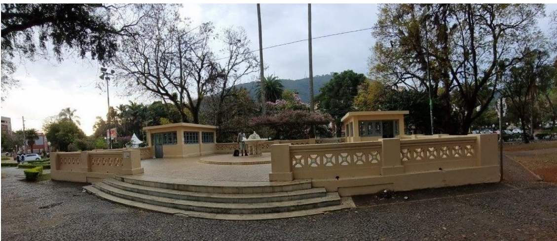
FONTE PEDRO BOTELHO. Vista da esplanada alteada e os dois cômodos que abrigam o fontanário e o acesso às captações que se localizam no subsolo.
