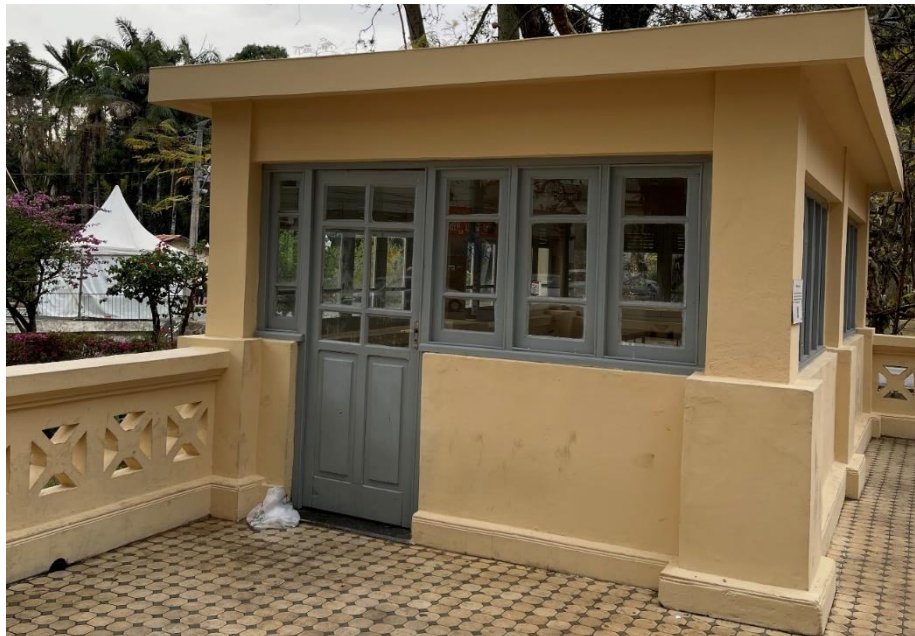
Casa de Bombas
