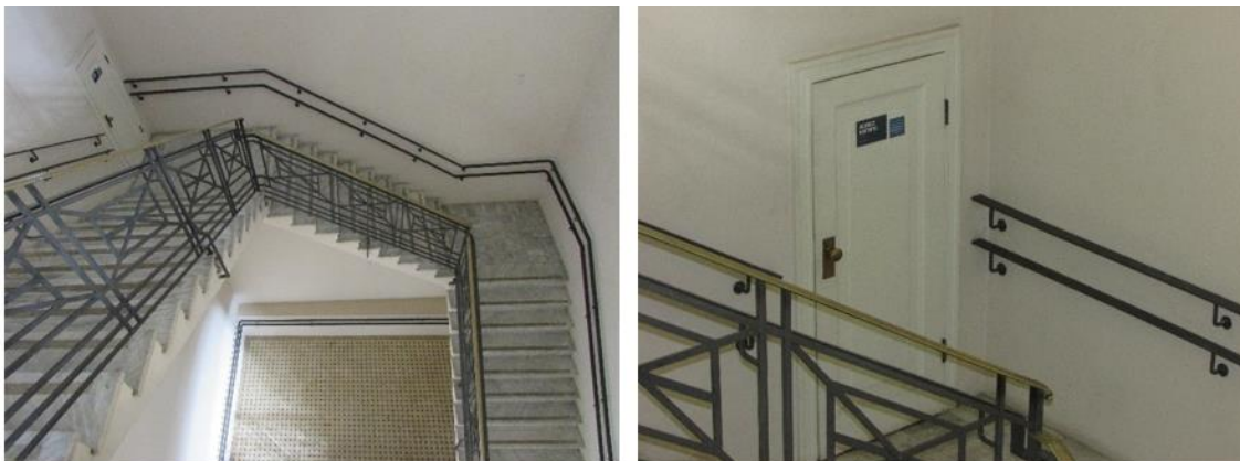
Entrada do pavimento técnico
